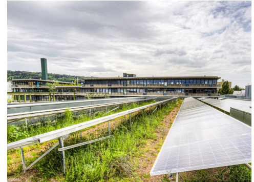
Beispiel einer Dachbegrünung in Kombination mit Photovoltaikanlage im ewz Unterwerk Oerlikon (Bild: ewz). Der Wirkungsgrad von Solaranlagen erhöht sich durch den Kühleffekt der Dachbegrünung um bis zu fünf Prozent.
